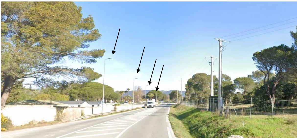
Figure 61 : Vue depuis la RD4 de l'alignement de lampadaires (Google street)
