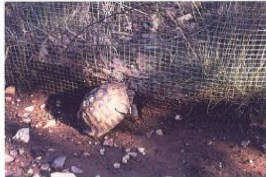
Photo 124 - A 57 (Toulon – Le Cannet des Maures) : dispositif de clôture (le grillage anti-tortue joue son rôle protecteur) Source : J. Casignol (CETE de l'Est)
